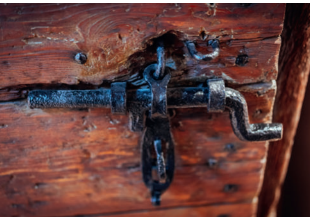
Original erhaltene mittelalterliche Beschläge und Riegel an bestehenden Holztüren
